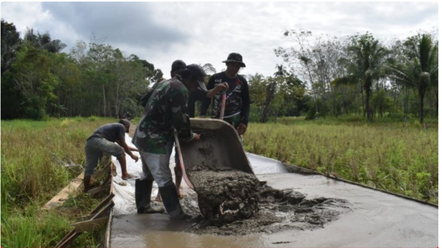
TMMD ke-116 Kodim 1002/HST Terus Genjot Pengerjaan Jalan
